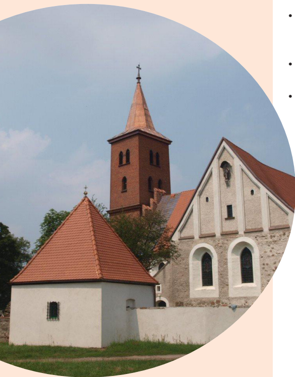
Kościół w Osetnie po remoncie
